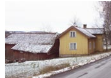
Alafors 3:3 F d jordbruksfastighet. Framkammarsstuga.
