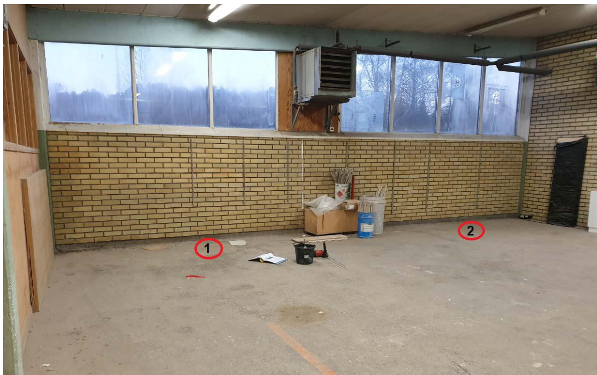
Figur 5. Provpunkterna 1 och 2 för porluftsmätningar.
