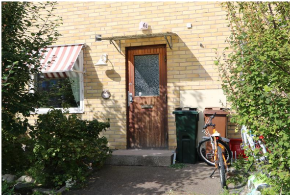
Bild 3. exempel på framsida med entrédörr och entrétak i original.
