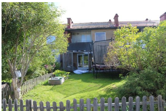
Bild 6. Exempel på baksida med fasad och balkong i original.
