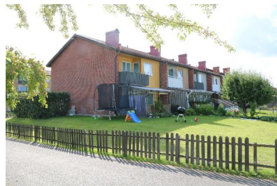
Bild 7. Exempel på hur baksidans fasad och balkonger förändrats.
