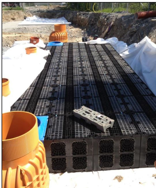
Figur 15. Installation av dagvattenkassetter.
