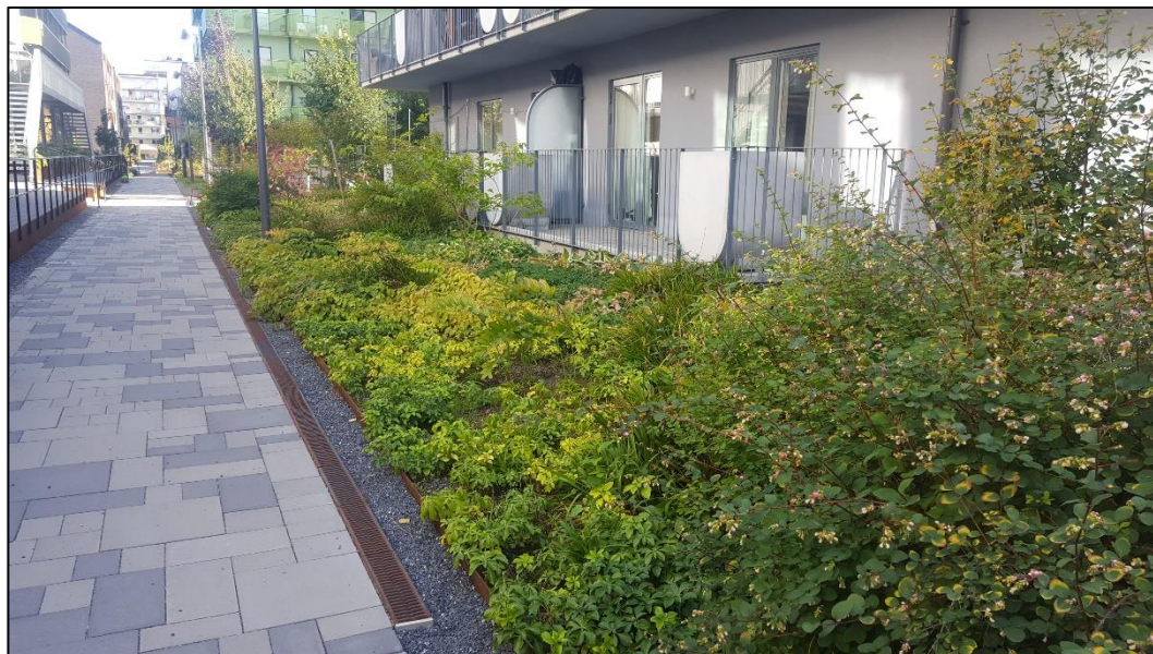
Figur 16. Exempelbild på regnbädd (Foto: Sweco).
