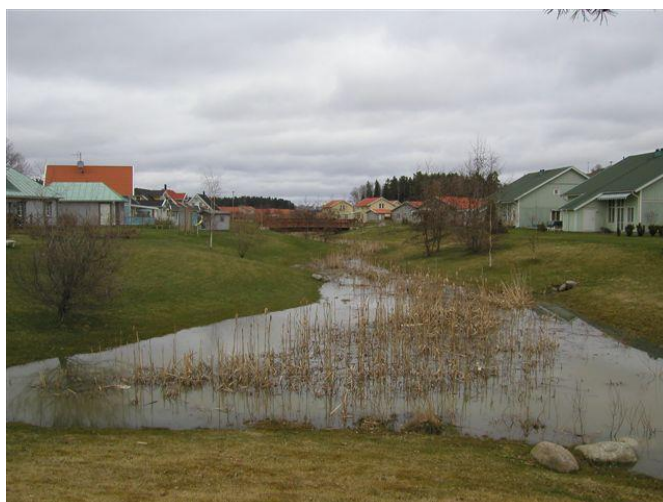
Figur 5 Ytlig avledning av dagvatten med genomtänkt höjdsättning i ett bostadsområde i Västerås. Foto: Sweco
