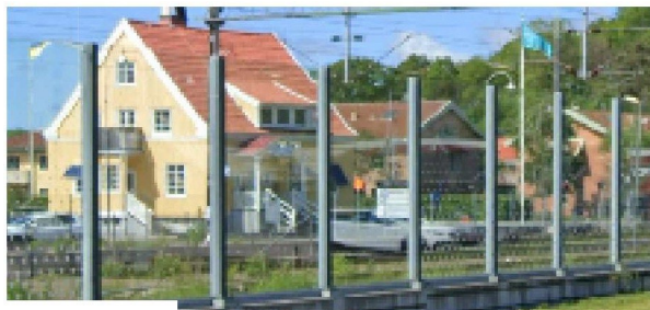
Figur 5 – exempel på transparent bullerskydd i närheten av Kungsbacka station
