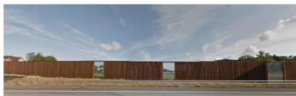
Figur 6 – exempel på bullerskydd i trä med transparenta inslag.
