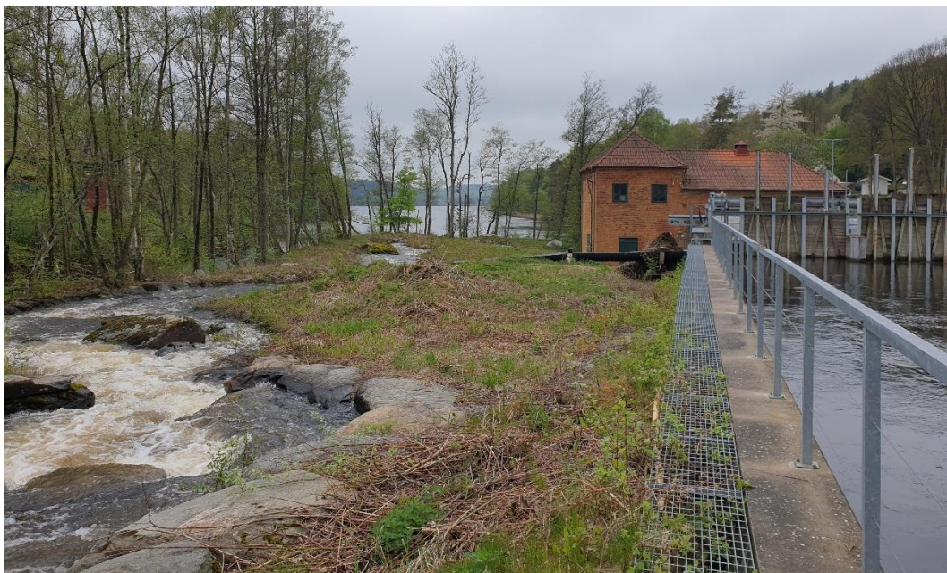
Figur 3: Ålgårda kraftverk med omlöp för fisk till vänster i bild. Foto: Helen Eklund
